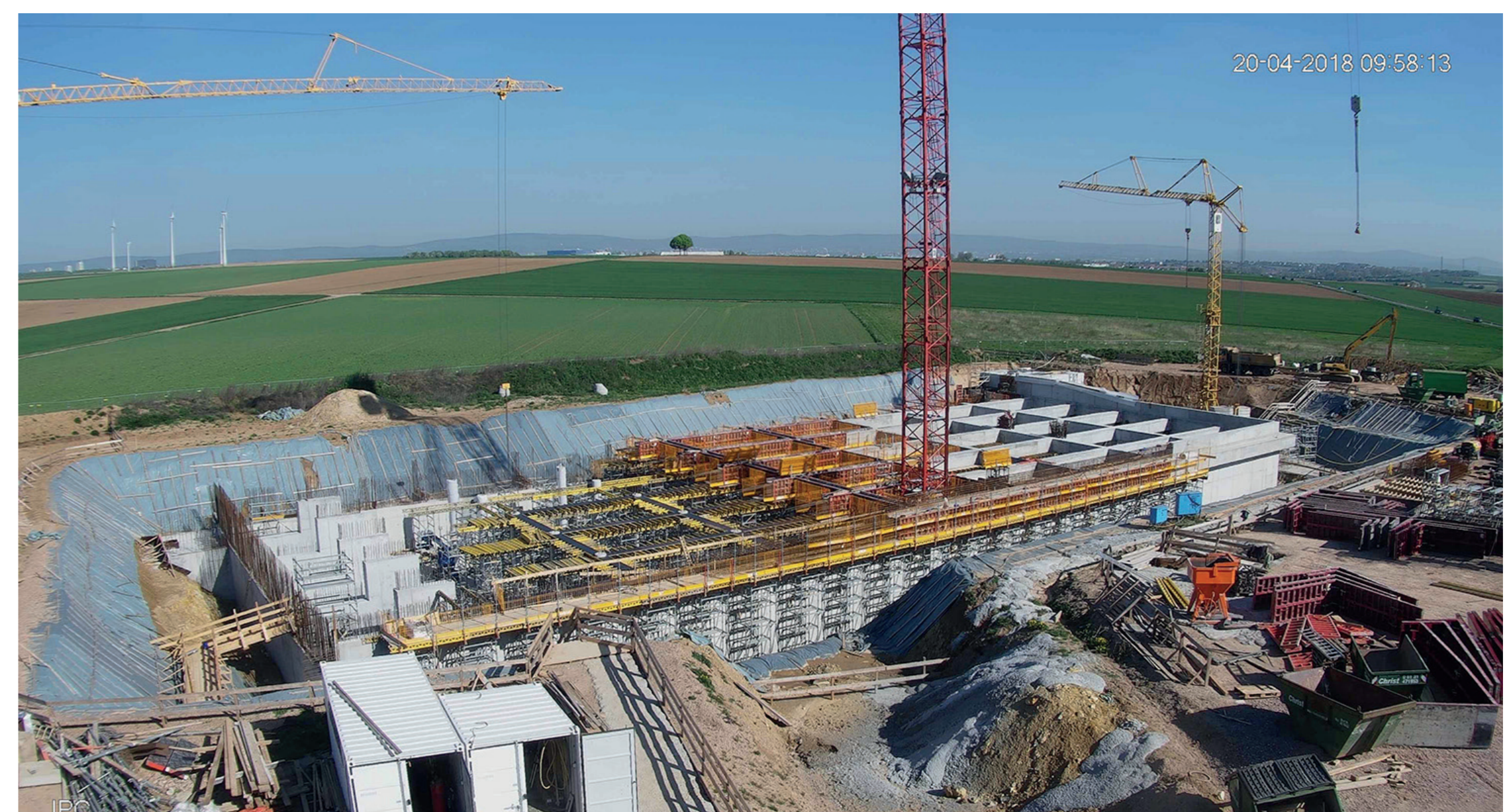
Verlegung Regenrückhaltebecken Ebersheim außerhalb des Ortskerns
