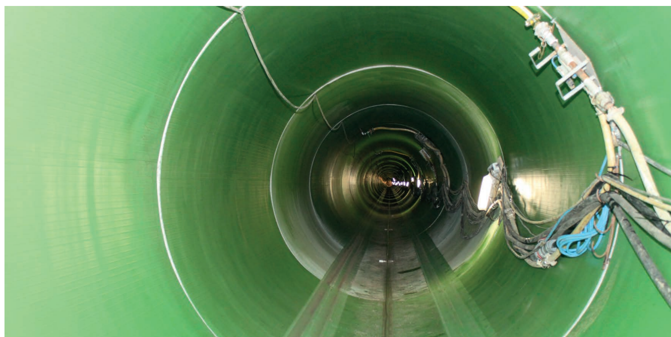
Neuer „Staukanal“ unter der Rheinallee
