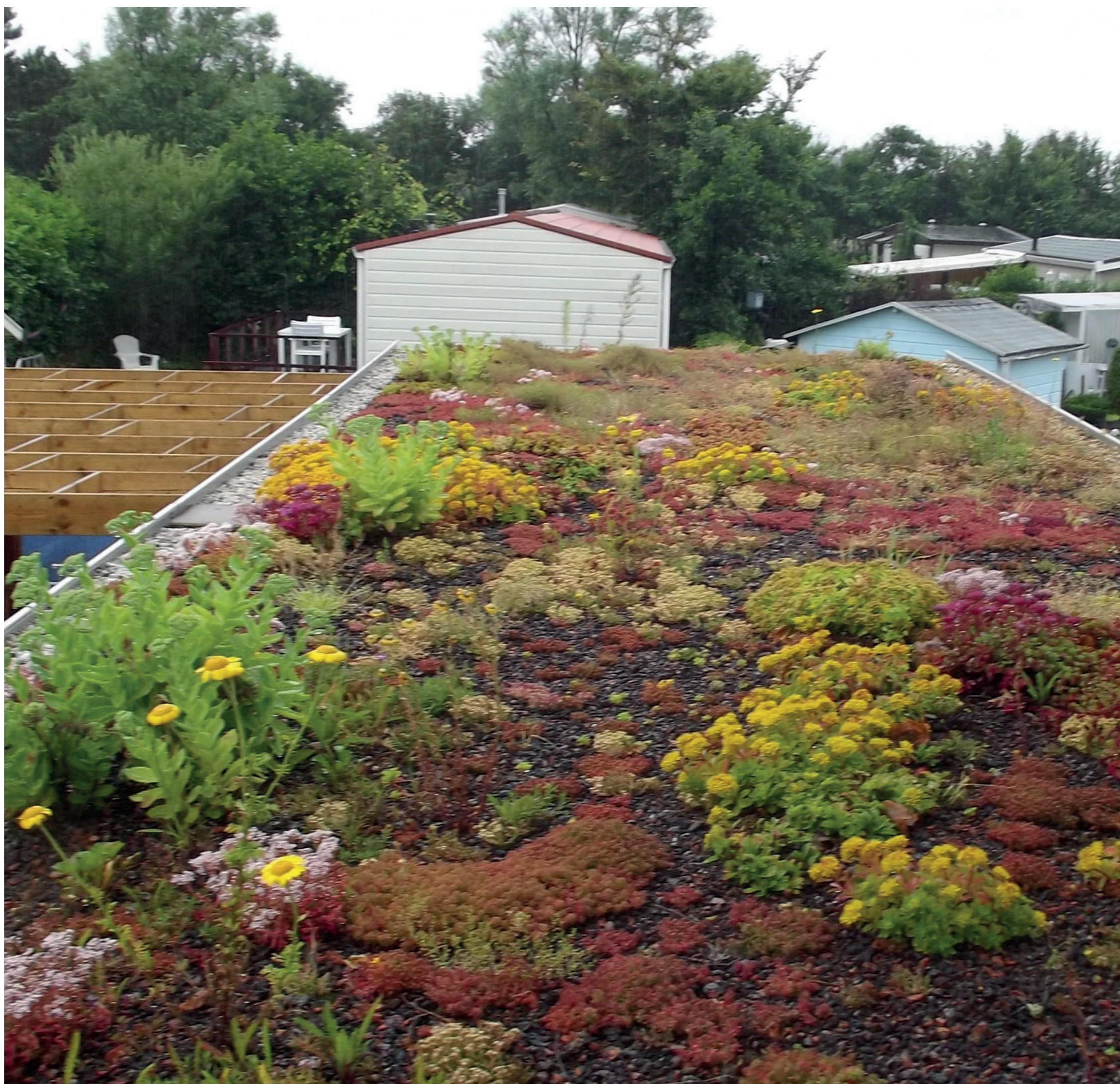
Dachbegrünung speichert Wasser
