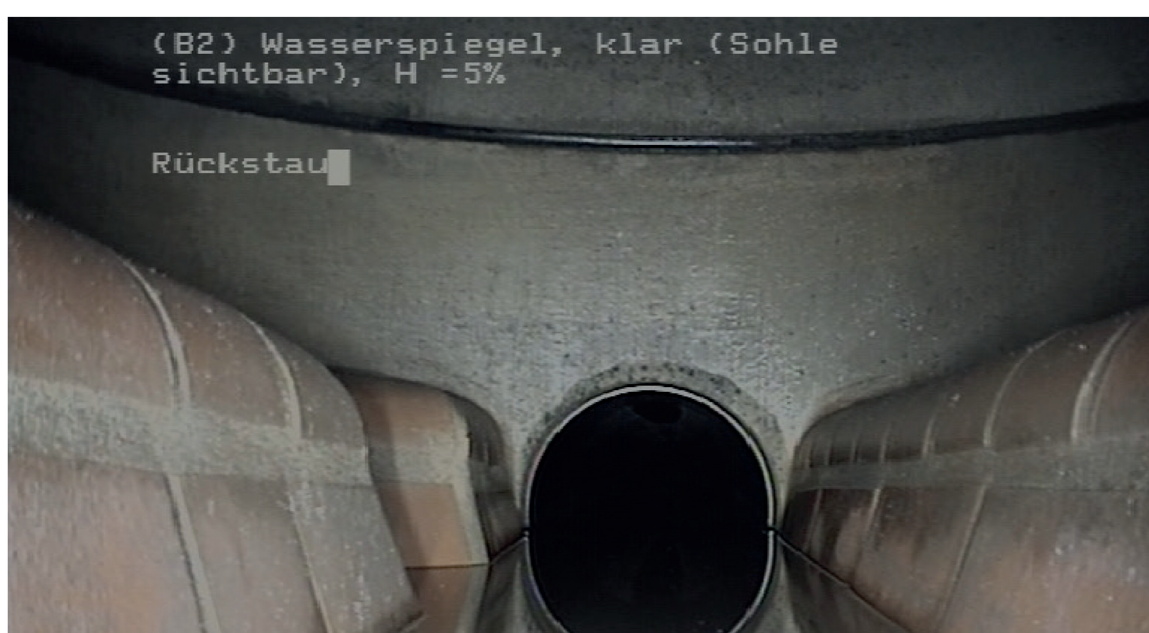
Regelmäßige Kontrolle und Wartung des Kanalsystems
