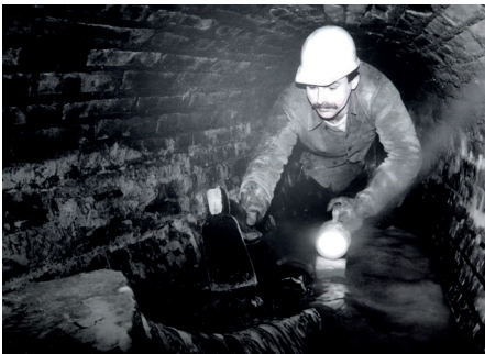
Früher: Kontrolle eines historisch gemauerten Kanals im Eiprofil
