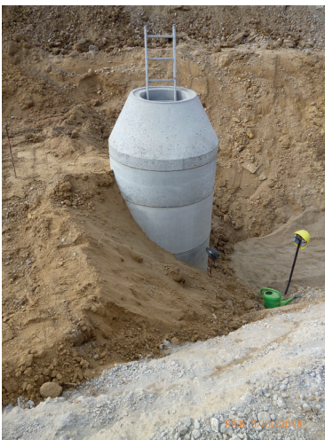
Kanalschacht im Bau
