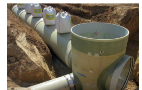
...und nach dem Einbau in den Staukanal
