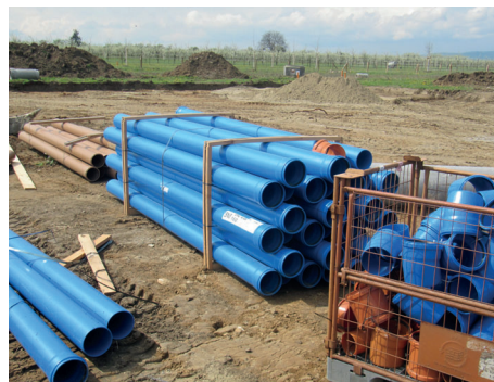
Polyvinylchlorid (PVC) oder die leichtere Alternative Polyethylen (PE): Hausanschlusskanäle für Regen-, Schmutz- und Mischwasser
