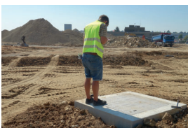
Abdeckung Drosselschacht nach dem Einbau und ein Blick...
