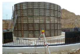
Bau eines der beiden Regenrückhaltebecken
