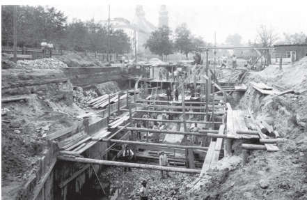
Bau des Hauptsammlers in der Großen Bleiche kurz vor der Einmündung in die Peter-Altmeier-Allee, im Hintergrund sind die Türme der Kirche St.-Peter zu sehen.
