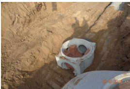
...und geklinkertem Fertigteilschachtbauwerk wird eingebaut
