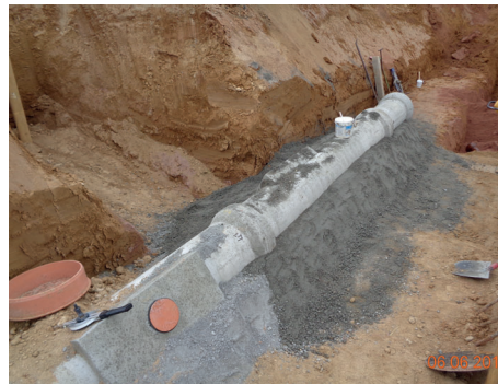
Stahlbeton: Nur für Regenwasserkanäle
