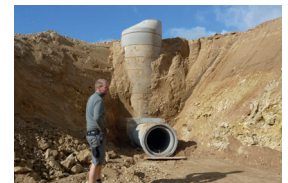
Und so werden die Teile verbaut: Ein Regenwasserkanal mit Zugangsschacht...
