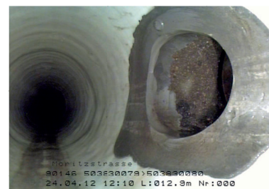
Sanierte Schadensstelle
