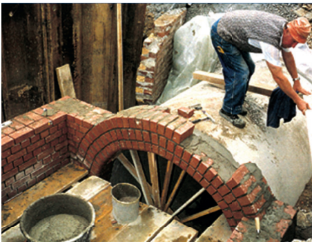
Klinker-Kanalbau - selten noch von Hand - in Schächten für Schmutz-, Misch- und Regenwasser
