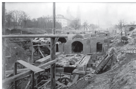
Bau des Hauptsammlers in der Großen Bleiche kurz vor der Einmündung in die Peter-Altmeier-Allee, im Hintergrund sind die Türme der Kirche St.-Peter zu sehen.
