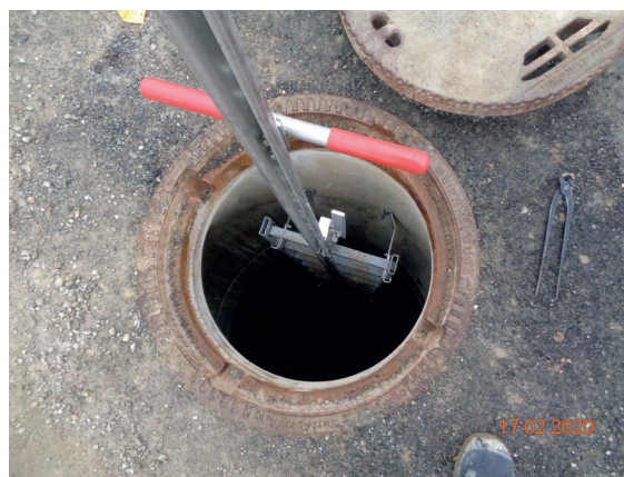
Blick in einen Kontrollschacht
