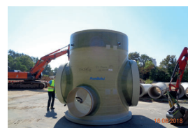
GfK-Schacht für Staukanal vor dem Einbau...
