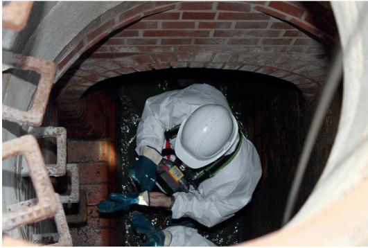
Der Einstieg in die Unterwelt: Direkte Kanalinspektion durch Mitarbeiter der Abteilung Abwassersammlung mit Schutz- und Sicherheitsausrüstung. Denn die Arbeit in der Unterwelt ist nicht ungefährlich.
