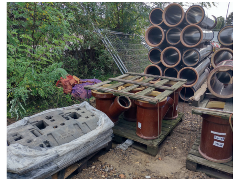
Steinzeug: Bei Hauswasseranschlüssen für Schmutz- und Mischwasser
