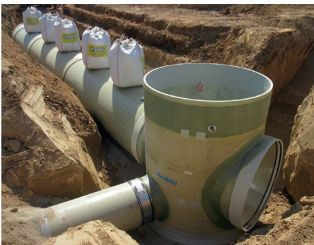
Glasfaserverstärkter Kunststoff (GfK): Stauraumkanäle (Foto: Fa. Weil) und reine Transportkanäle (ohne Hausanschluss) für Schmutz- und Mischwasser
