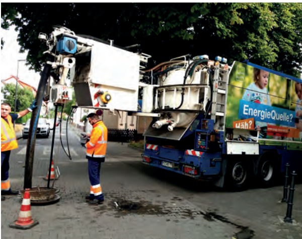
Saug-Spülfahrzeug im Einsatz
