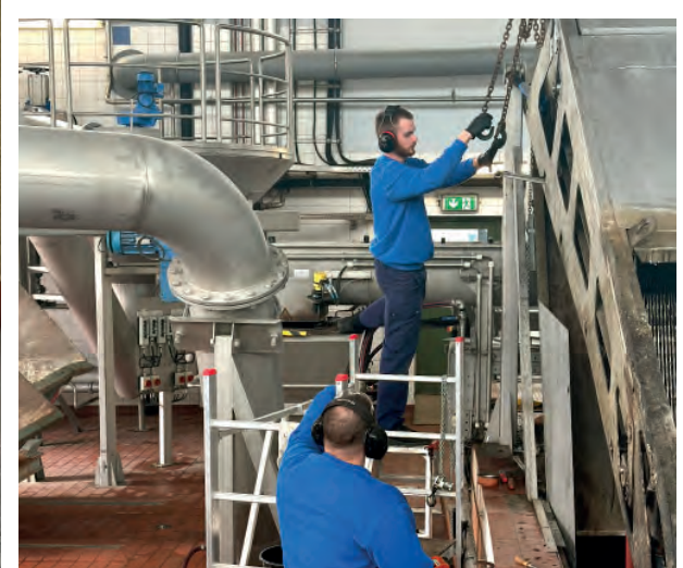
Wartungsarbeiten an der Rechenanlage
