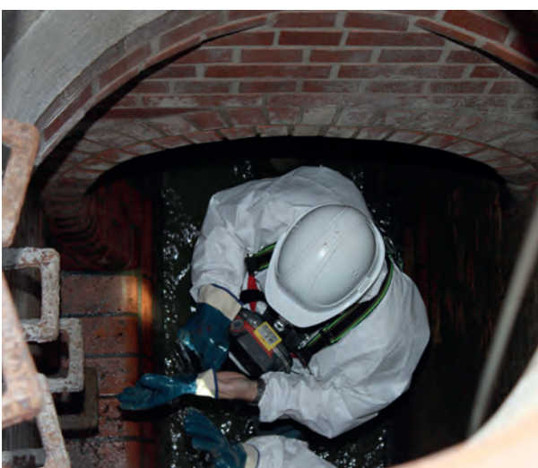
Kanalinspektion in Schutz- und Sicherheitsausrüstung
