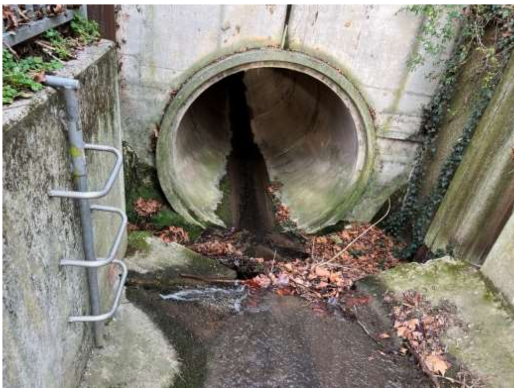
Abbildung 38 Einlaufbereich Verrohrung am Parkplatz des Rodeneck-Platzes (Blickrichtung in Fließrichtung)
