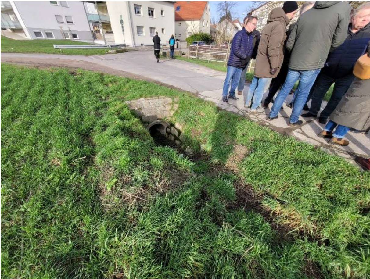
Abbildung 18: Einlaufbauwerk vom Entwässerungsgraben für Außengebietswasser
