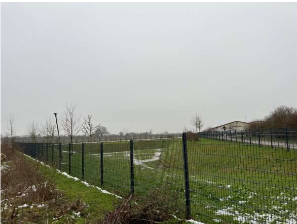
Abbildung 62: RRB im Norden des Neubaugebiets
