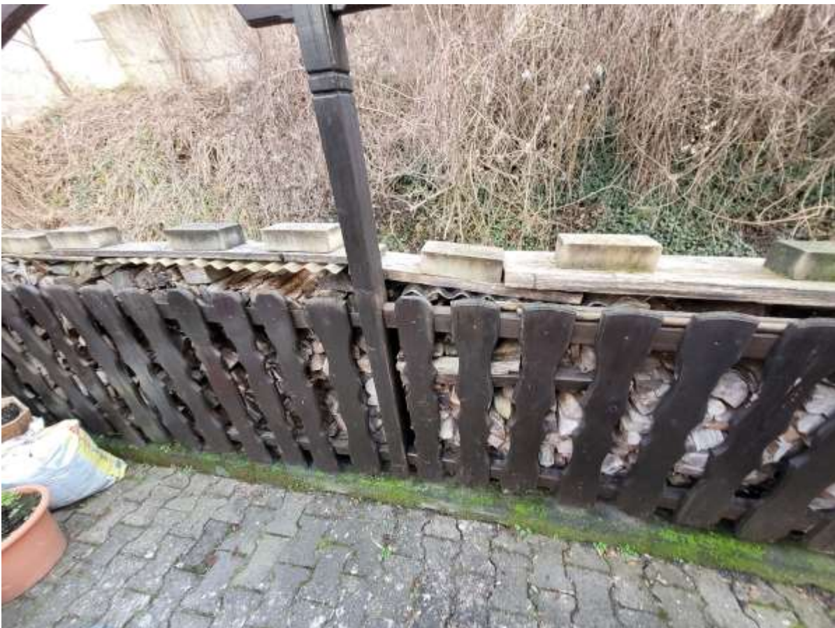
Abbildung 57: Lagerung von Schnittholz direkt am Aubach
