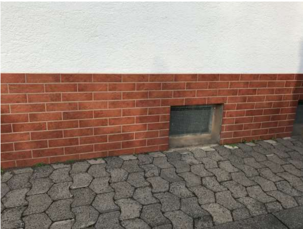
Abbildung 44: Schutz der Kellerfenster vor Oberflächenabfluss in der Prunkgasse
