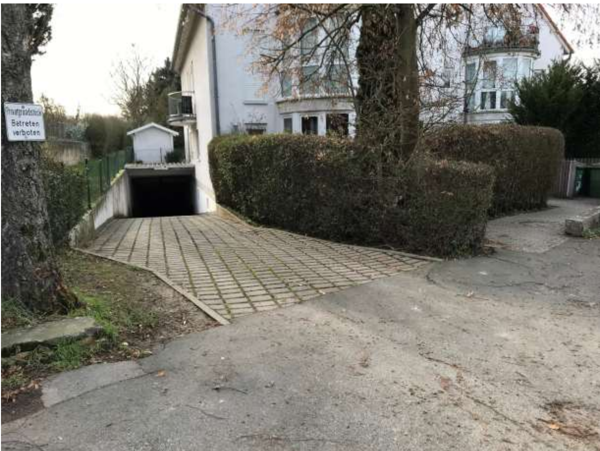
Abbildung 27: Gefährdete Tiefgarage in der Straße „Am Draisberg“
