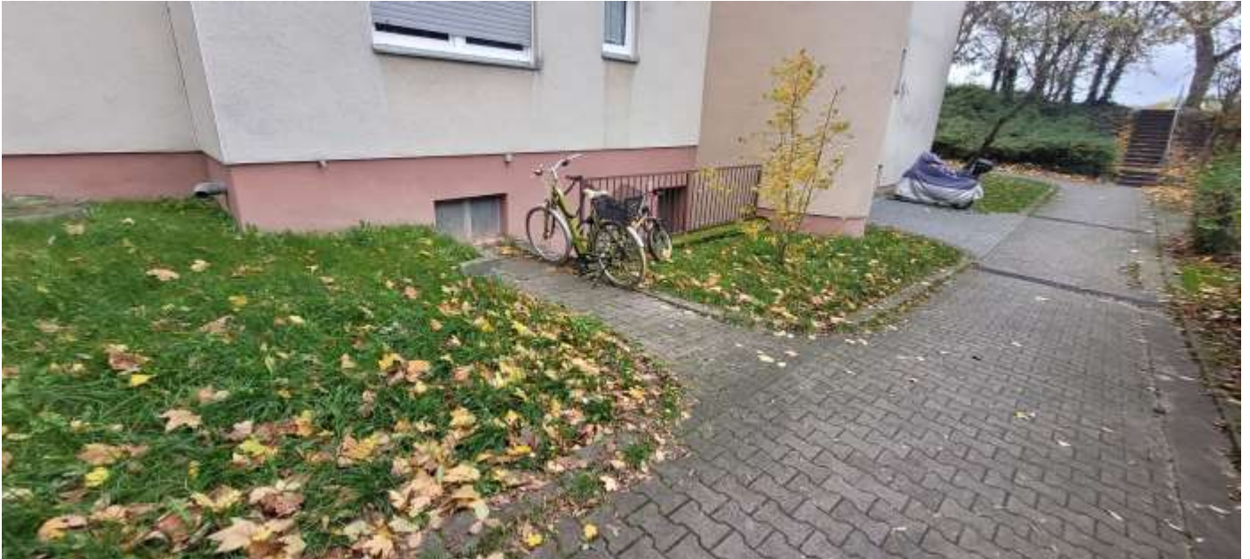
Abbildung 83: tiefliegende Kellereingänge im Bereich von Haus Nr. 353 des Sertoriusrings
