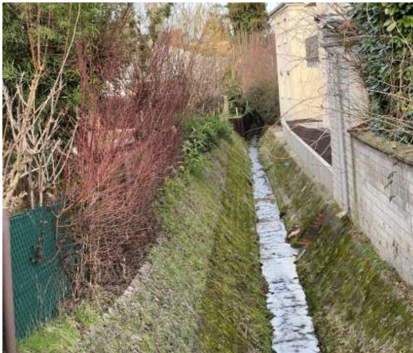
Abbildung 49: Neubau Haus Nr. 8 in der Aubachstraße
