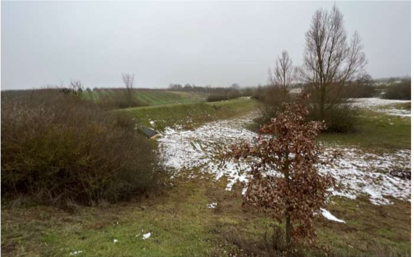
Abbildung 2: östlicher Bereich des RRB Layenhof
