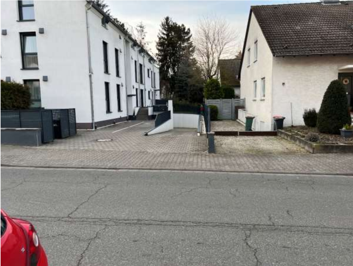
Abbildung 54: ebenerdige Eingänge und Tiefgarage in der Gonsenheimer Straße
