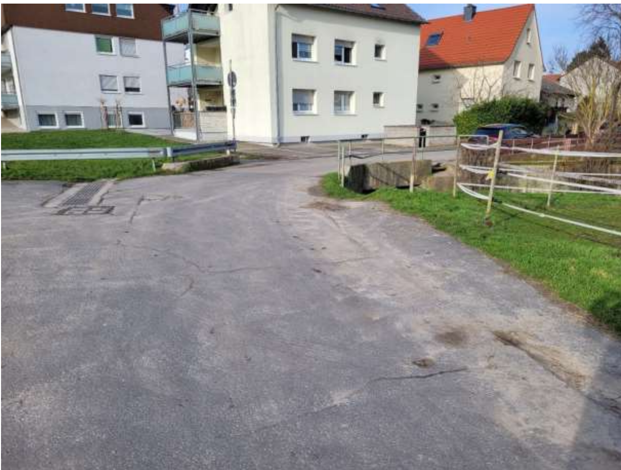
Abbildung 19: Schwerlastrinne und oberirdische Wasserleitung in den Aubach
