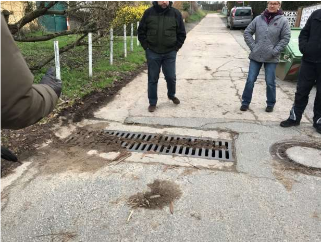
Abbildung 26: Schwerlastrinne auf der Straße „Am Draisberg“
