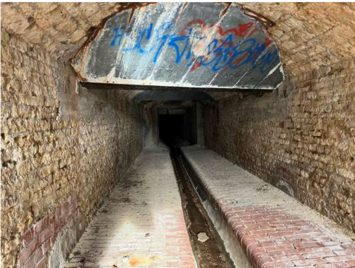
Abbildung 24: Bereich des Bachgewölbe unter der Hauptstraße (Blick in Fließrichtung)
