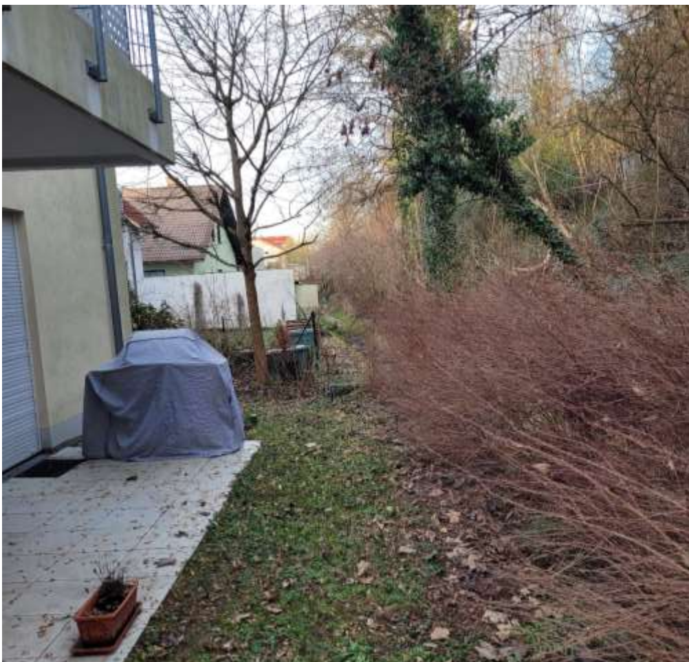
Abbildung 55: Haus mit ebenerdigem Eingang direkt am Aubach
