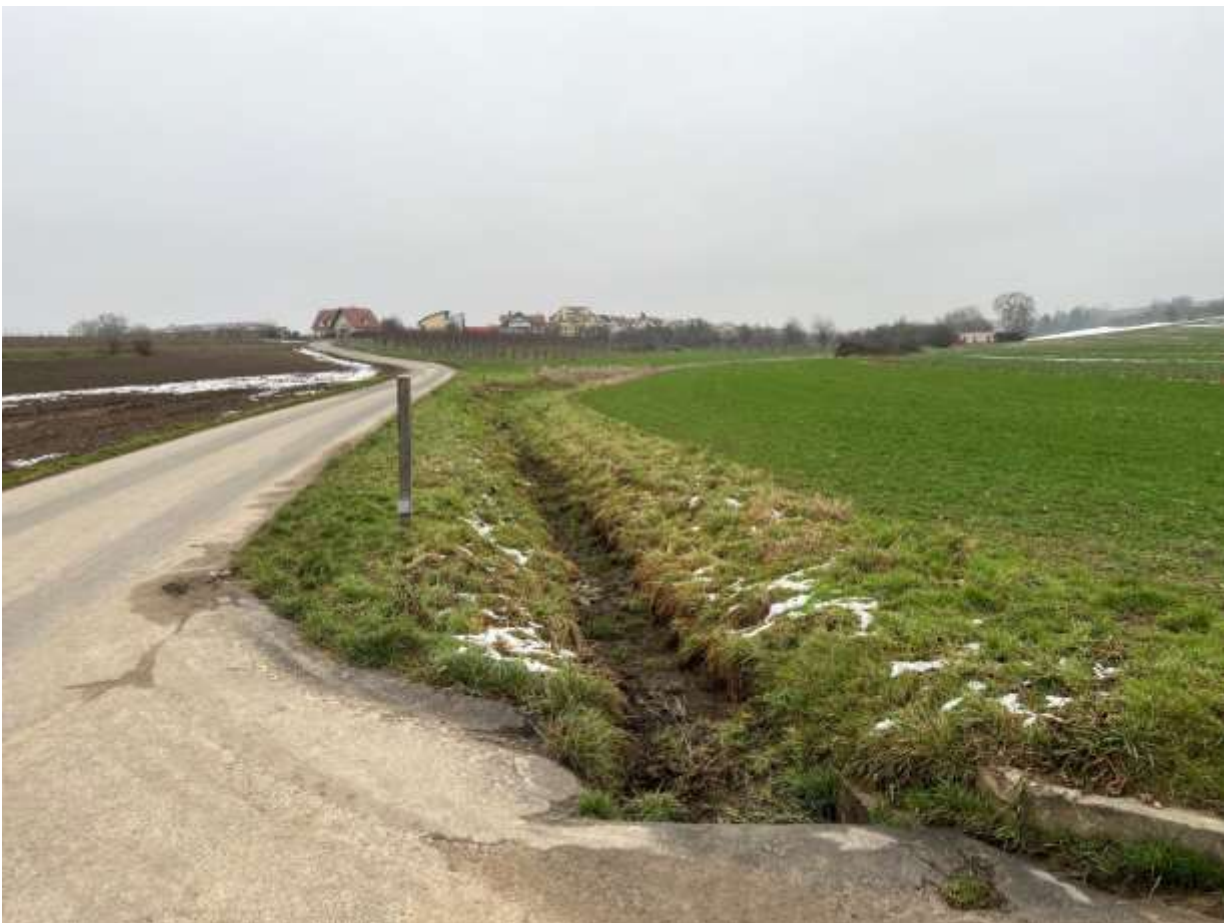
Abbildung 12: Erhöhte Bachsohle im Kurvenbereich des Aubachs (Blickrichtung in Fließrichtung des Aubachs)
