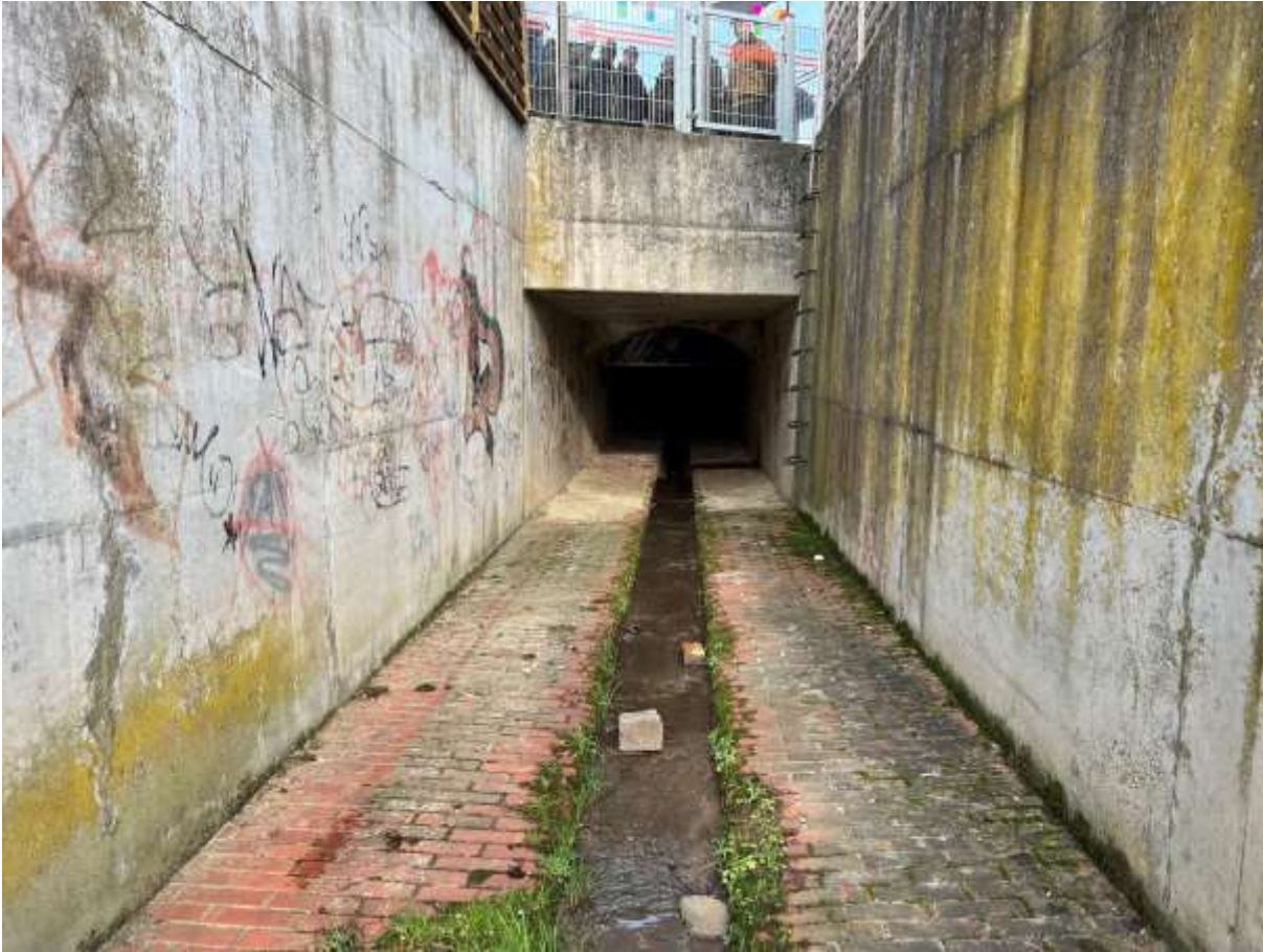
Abbildung 23: Beginn Bachgewölbe (Blick in Fließrichtung)
