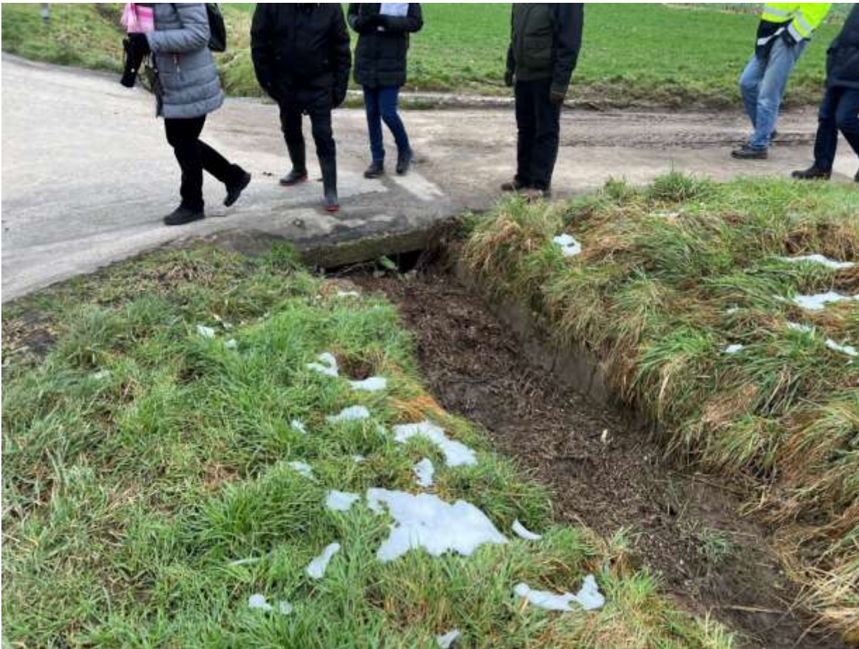
Abbildung 11: Durchlass unter dem Wirtschaftsweg (Blickrichtung in Fließrichtung des Aubachs)
