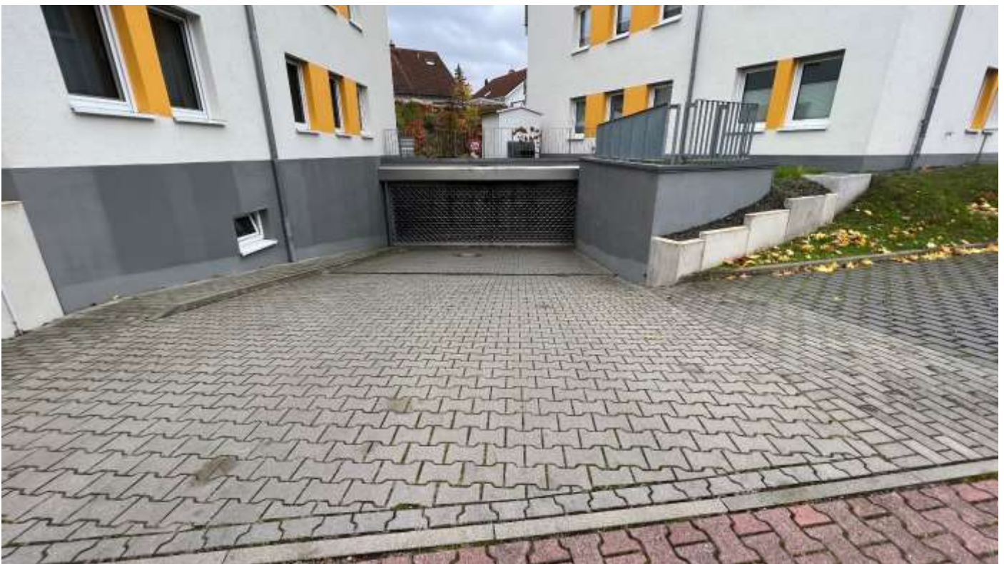
Abbildung 92: Tiefgarage im östlichen Bereich des Sertoriusrings
