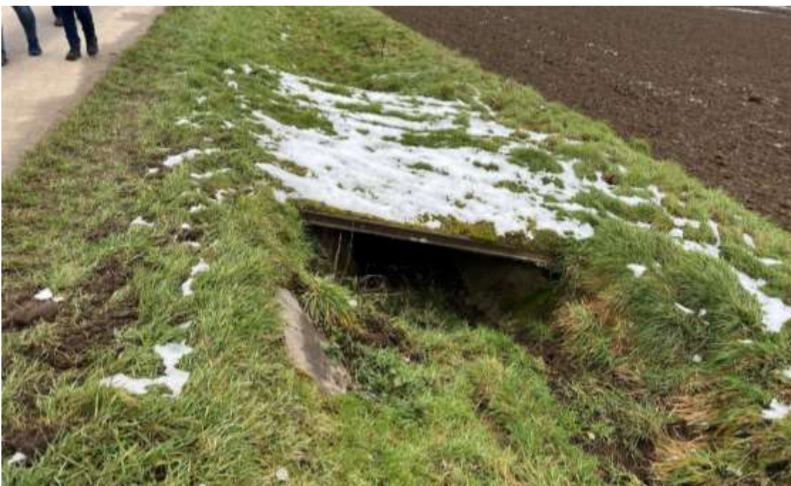
Abbildung 7: Durchlass (Blickrichtung in Fließrichtung)
