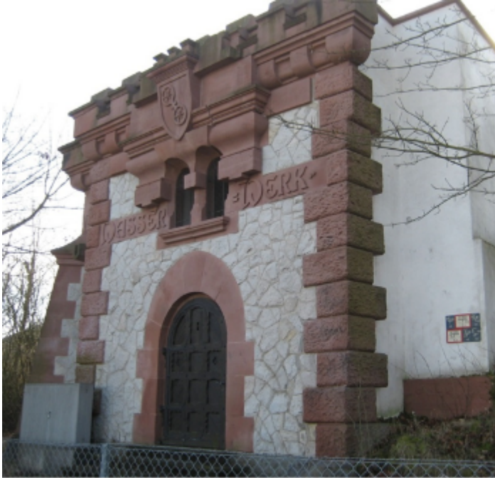
ehemalige Trinkwasserzisterne der Stadtwerke Mainz, Weisenauer Weg in Hechtsheim
