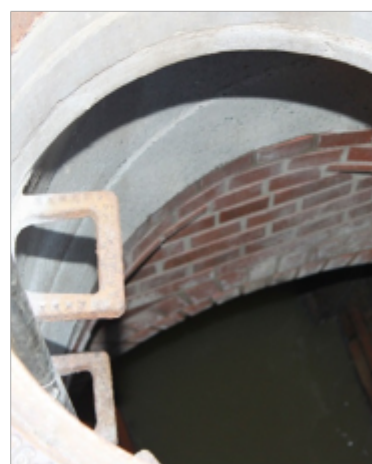
Kanalschacht in Klinkersteinen und Beton
