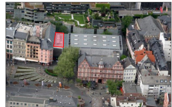
Mögliche Aufstellfläche Rückkühlung
