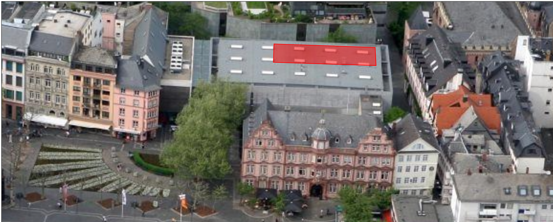
Möglicher Aufstellbereich Lüftungsanlage
