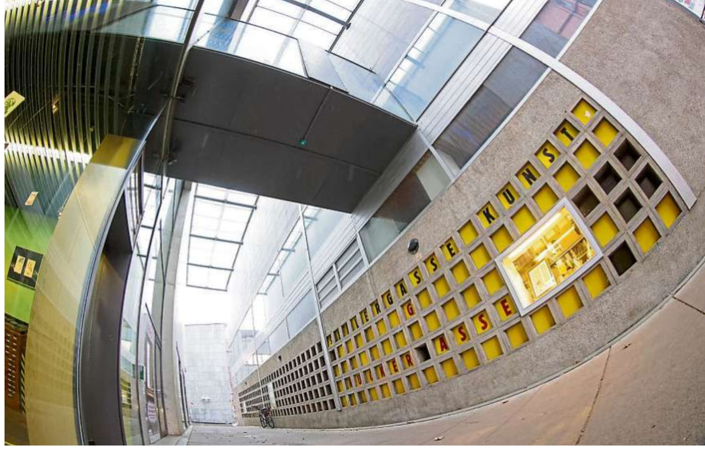
Die Seilergasse darf laut Auslobungstext verschoben und überbaut werden, der Durchgang muss aber gewährleistet bleiben. Foto: Kopp
