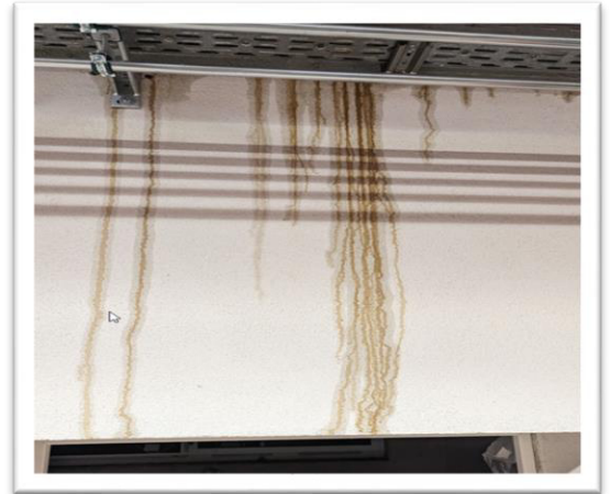
Abbildung 12: Anschlussarbeiten Wassereintrich
