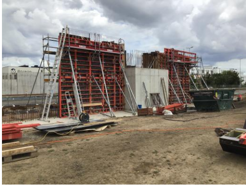
Abbildung 5: Brücke Saarstraße I
