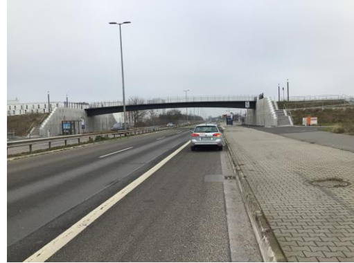
Abbildung 6: Brücke Saarstraße II
