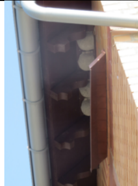
2.Ersatznisthilfen nach Sanierung
