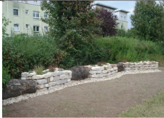
5. Anlage einer Trockenmauer
