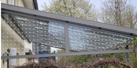
2. Nachrüstung durch Folie, Terrasse in Hechtsheim
